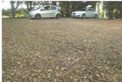
La densité du produit limite la formation d'ornières lors du passage de véhicules.
